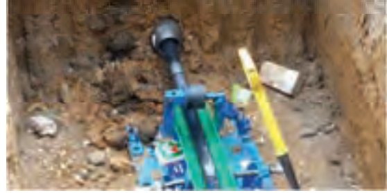
चित्र. 2.1.17 अपने लॉन्च पिट में इम्पैक्ट मोलिंग हैमर
