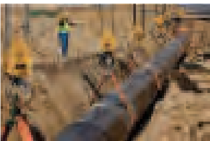
चित्र 4.3.19 असुरक्षित स्थिति में पाइप को नीचे डालना (खाई के बिलकुल किनारे खड़ा होना)
