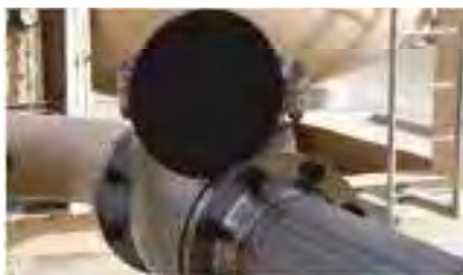
Fig. 1.5.12 Spectacle blind flange -open
