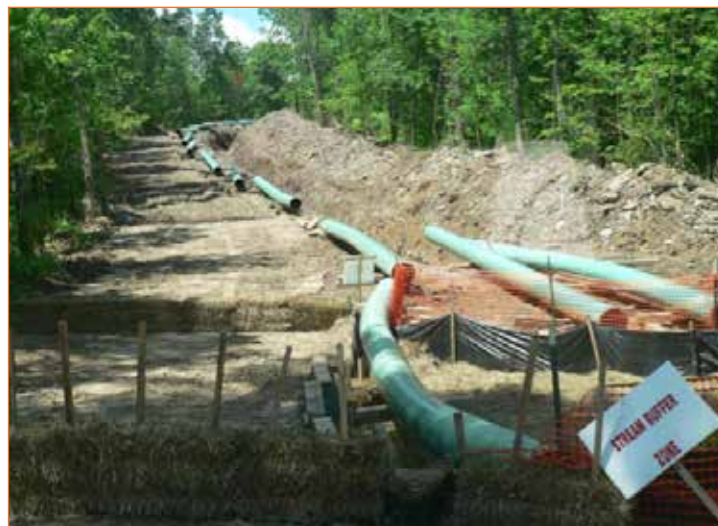
Fig: 2.1.13 Stringing pipe
